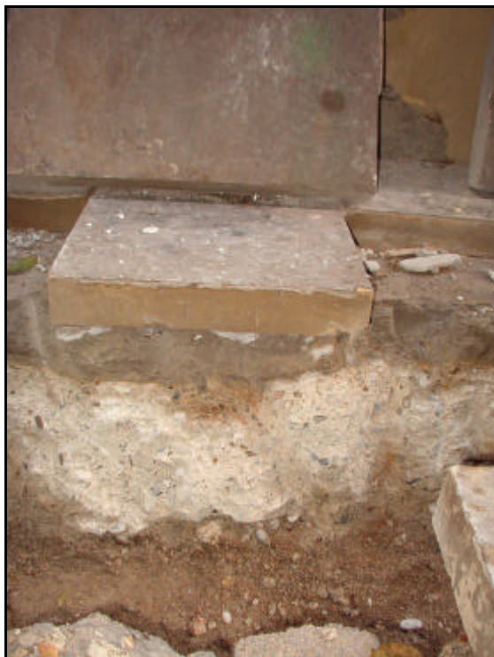
Fotografia núm. 4. Detall de l'estratigrafia de la Rasa 500 (hi podem veure el paviment amb les seves dues capes de preparació de formigó -501- i el sauló -502-). Mirant cap al nord-est.
